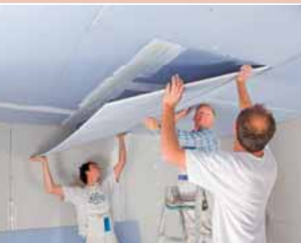
Besserer Schallschutz bei Holzbalkendecken mit Knauf Diamant.
