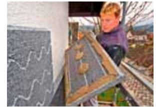
Mit dem WARM-WAND-System Duo lassen sich alte WDVS-Fassaden energetisch optimieren.
